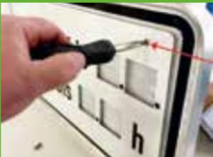
Sicherungsschrauben lösen (M6x16)
